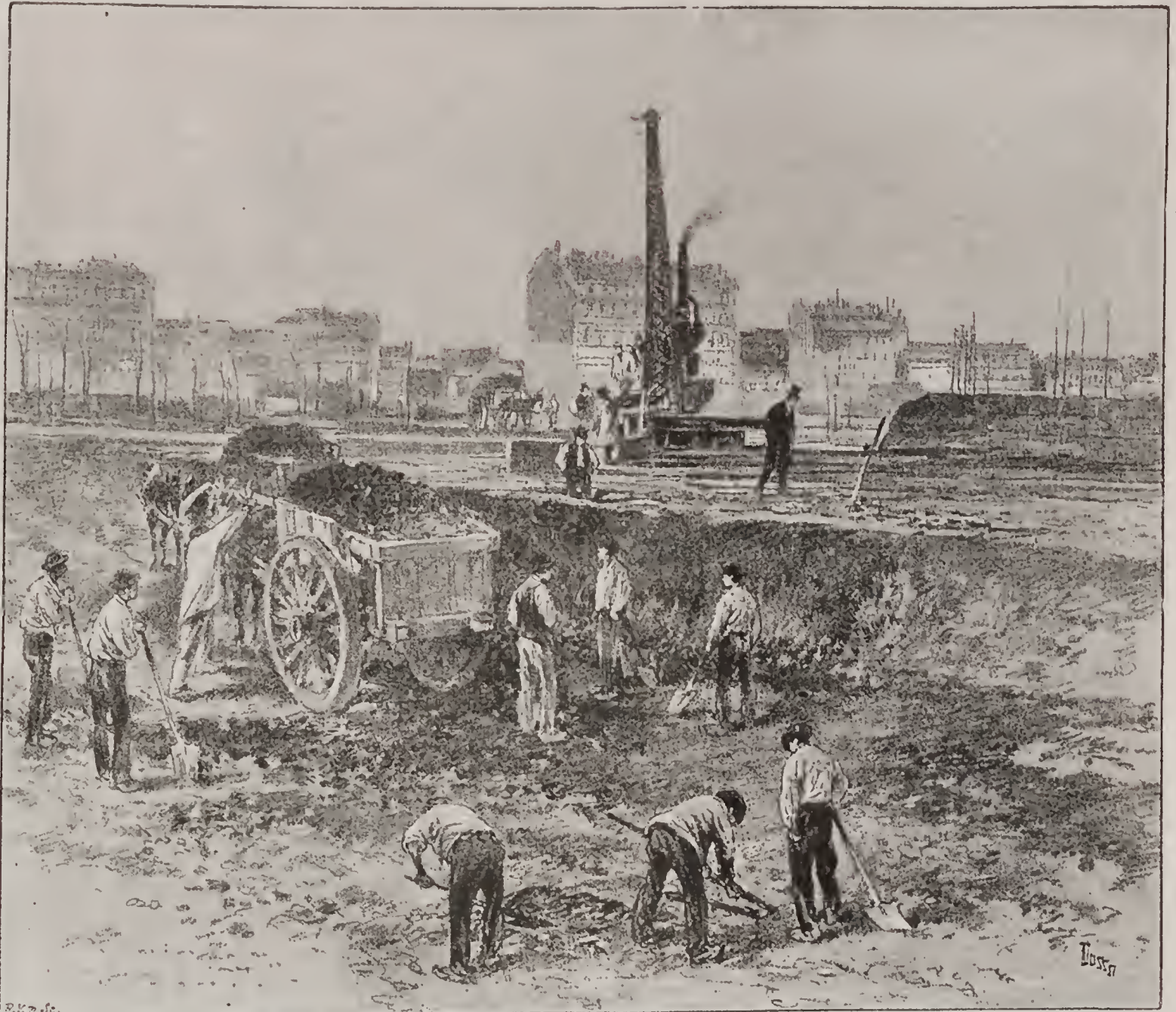
LES INSTALLATIONS MÉCANIQUES. — 1. Les fouilles de l'usine Suffren, pour l'installation des foyers. — 2. Construction des carneaux de fumée.
